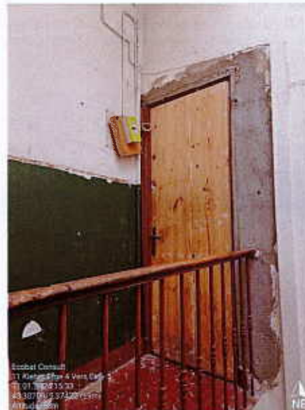
• Fixation du coffret linky • Vérification du réseau CFO • Vérification de la reprise de l'encadrement de la porte palière logement de droite (après sondage destructif)
