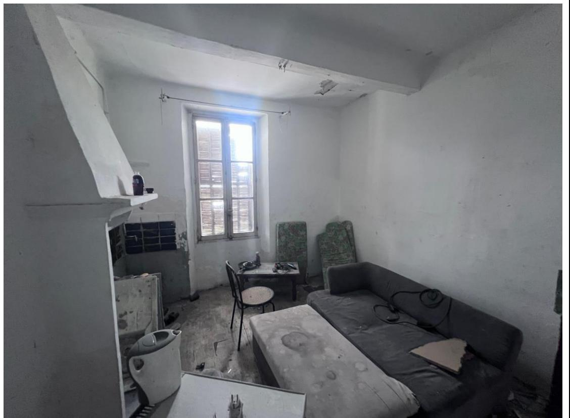
Le sol est recouvert de tomettes rouges hors d'état d'usage partiellement recouvert d'un gerflex hors d'état d'usage.
